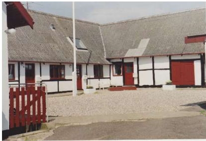
”Den gamle Gård”, Tingvej 28, 1991, nordvesthjørnet.
